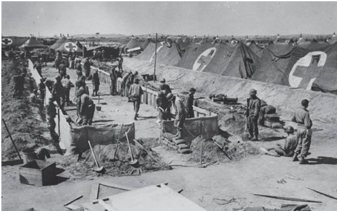
En la zona del hospital y la morgue en Anzio, las tropas, a principios de abril de 1944, cavan una nueva zanja para otro hospital de campaña amenazados por la artillería alemana y los ataques aéreos. Dos meses antes, un piloto de la Luftwaffe hizo explotar sus bombas sobre un hospital durante un ataque a la cabeza de playa y mató a veintiocho personas, entre las cuales tres enfermeras, dos doctores y seis pacientes.
